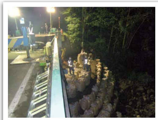
地域の建設業は「安心・安全」を最前線で支えている(写真は2010年8月に豪雨で被災した道道旭川旭岳温泉線上忠別橋の復旧作業)
